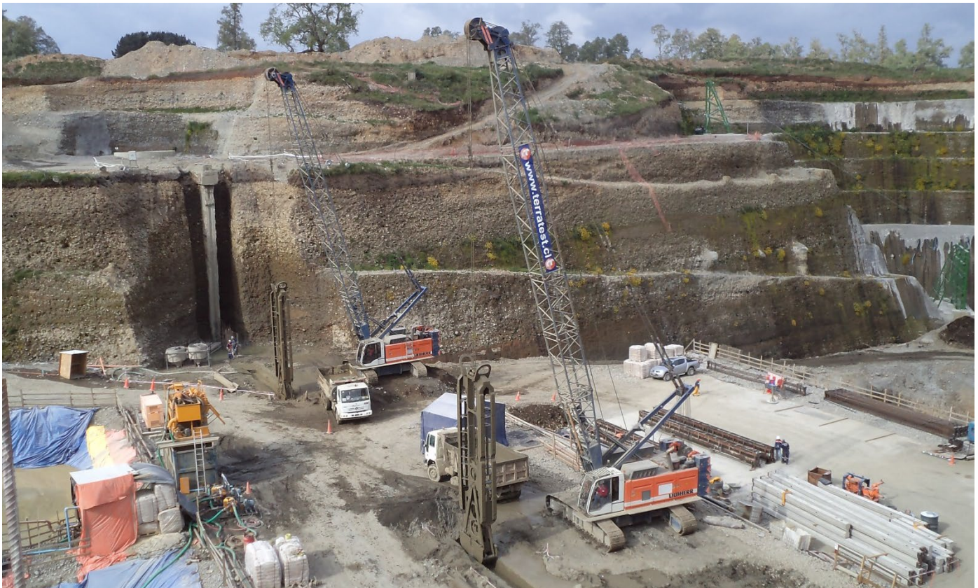
Vista general de la obra.
