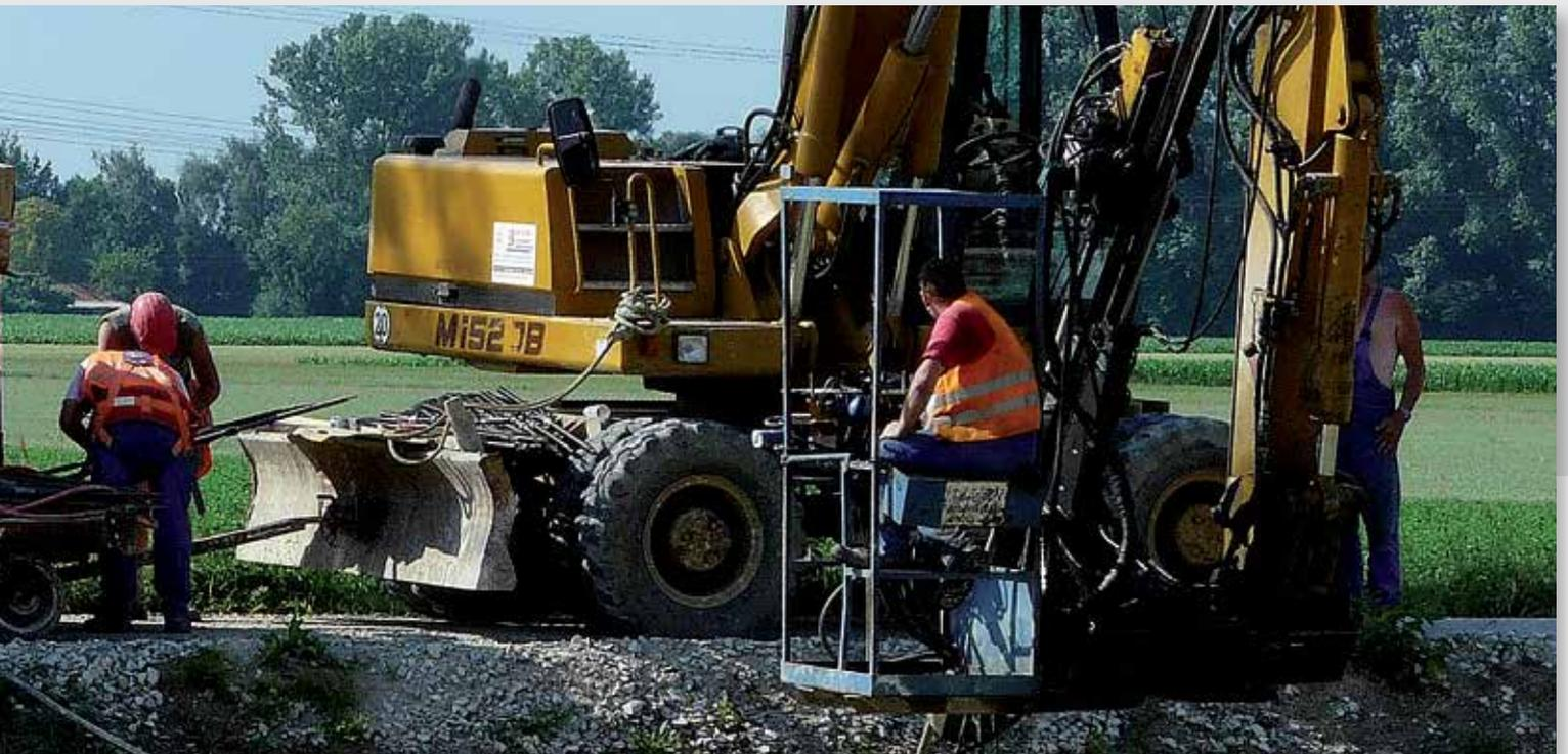
Los micropilotes TITAN con un diámetro nominal ( $D_{\text{acero}}$ ) hasta 40 mm pueden ejecutarse con martillos manuales neumáticos. Para diámetros nominales  $D_{\text{acero}} = 52$  mm puede usarse cualquier maquinaria hidráulica con rotopercusión y mástil.
