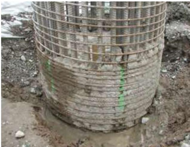
**Figura 9.** Ejemplo de estribos dobles para aumentar la distancia libre y permitir el ejemplo del hormigón (los separadores de la foto son inadecuados!)
