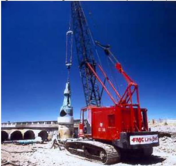
Paralelamente al desarrollo de la excavación con el sistema originalmente denominado "Benoto" (o sea, con morsa osciladora, cuchara y trépano), en la década de los '90 aparecieron en Chile los primeros equipos de perforación por rotación.
