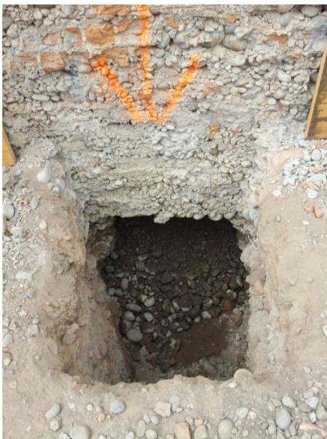
Foto 3. Primeros intentos de excavación por debajo de los cimientos resultaron en la falla local del relleno posterior
