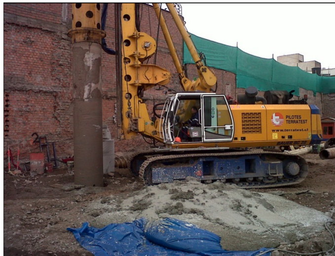
Foto 2. Foto durante la perforación de un pilote columna de 1m de diámetro mediante máquina pilotera tipo Bauer BG-24
