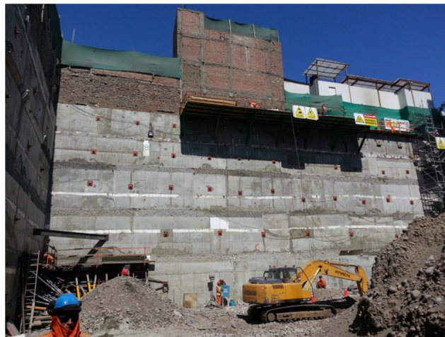
Foto 5. Se aprecia el muro del eje 7 del proyecto concluido con las 5 líneas de anclajes ejecutadas.
