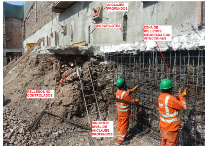
Foto 4. Se aprecia la primera fase de excavación por debajo del muro con anclajes profundos y micropilotes. La zona de rellenos se mejoró con inyecciones tipo lanza.
