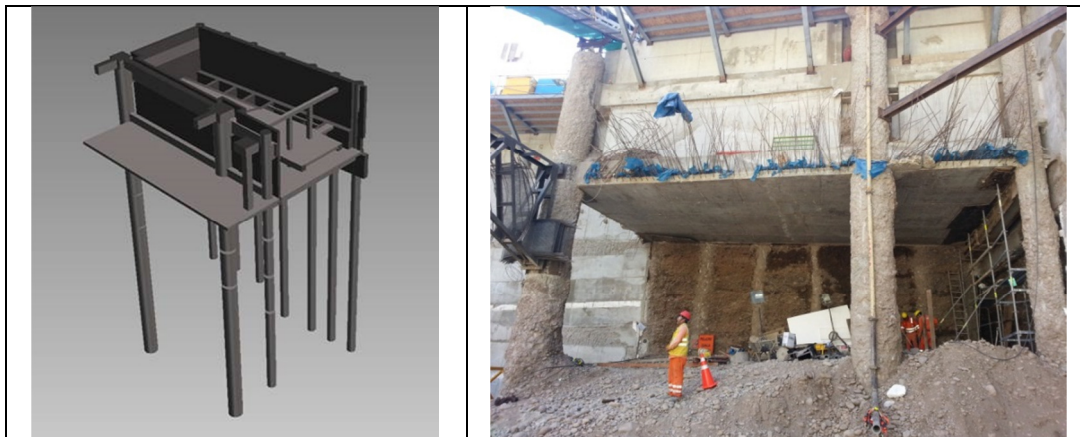
Figura 3. Izq: Esquema 3D de la solución top-down para el nuevo emplazamiento de la subestación. Der: Foto durante los trabajos de excavación debajo de la nueva subestación.
