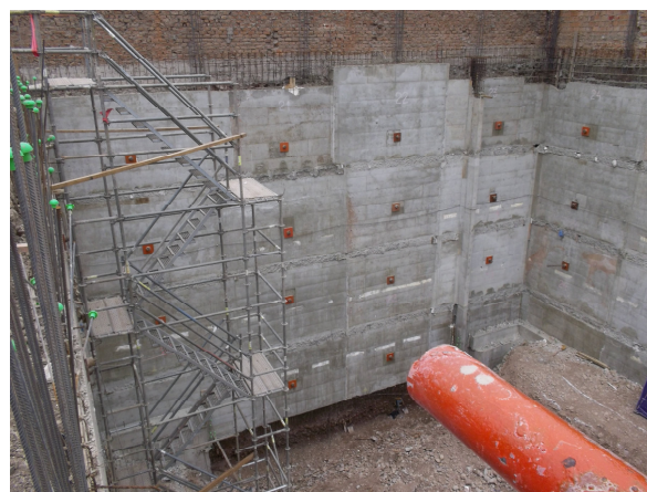
Figura 4. Muro anclado concluido e inicio de los trabajos de cimentación. Foto obra “Edificio Cipreses”.
