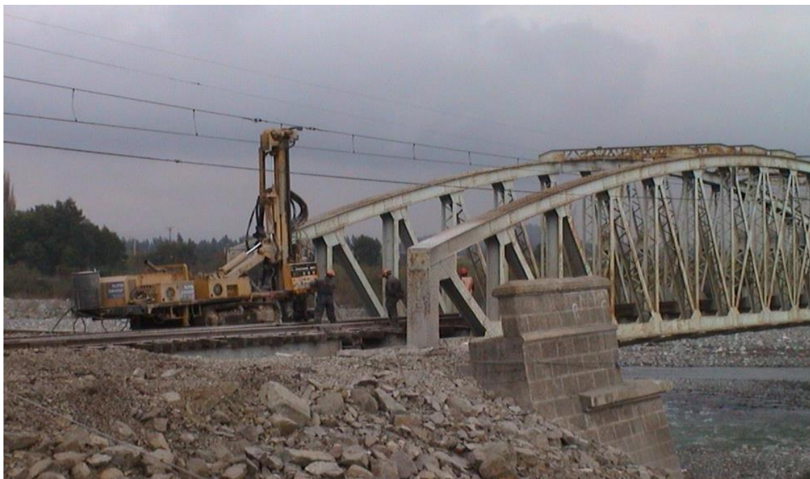
FIGURA 7 Refuerzo con micropilotes del estribo del Puente Tinguiririca
