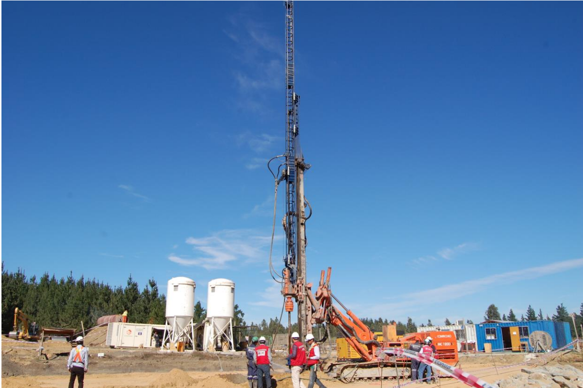
FIGURA 11 Equipamiento de trabajos de jet grouting.
