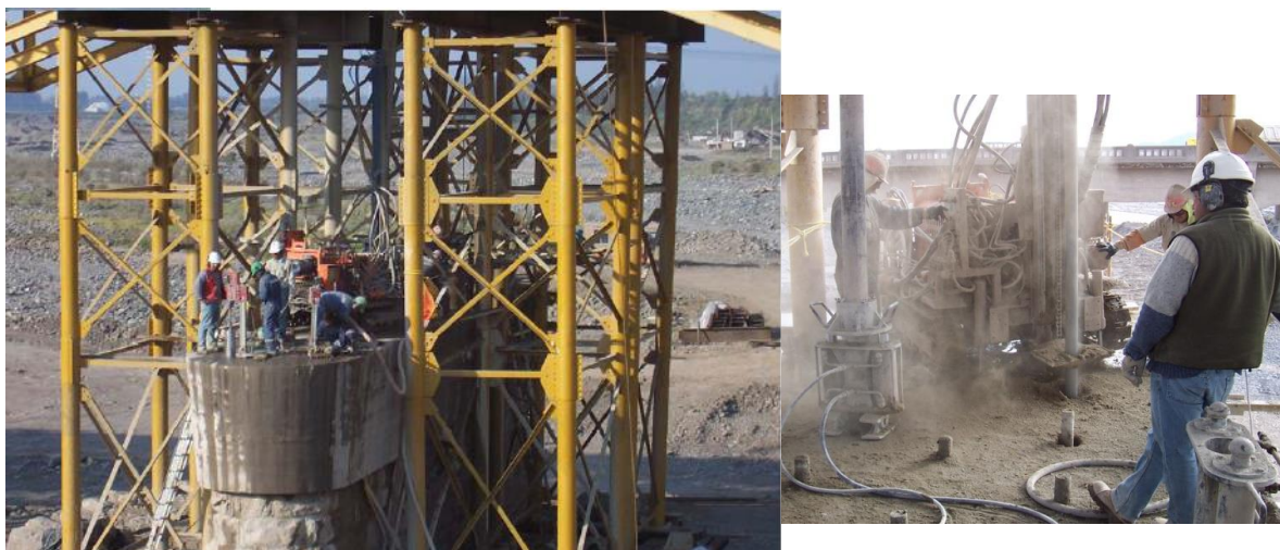
FIGURA 5 Ejecución de micropilotes sobre la cepa 8.
