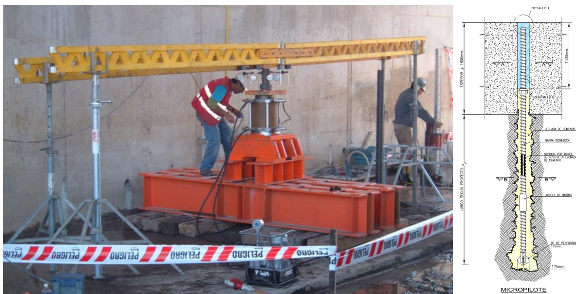
FIGURA 4 Ensayo de carga a tracción de los micropilotes y su conexión.
