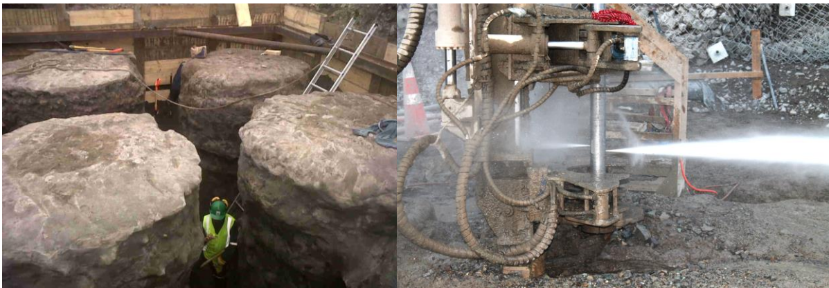
FIGURA 12 Campo de pruebas de columnas con ajuste de parámetros, y prueba con agua del monitor
