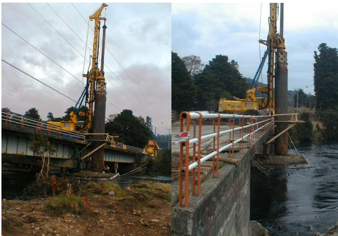
FIGURA 17 Puente Maullín (8 pilotes \phi 1500\text{mm} de 16 metros).
