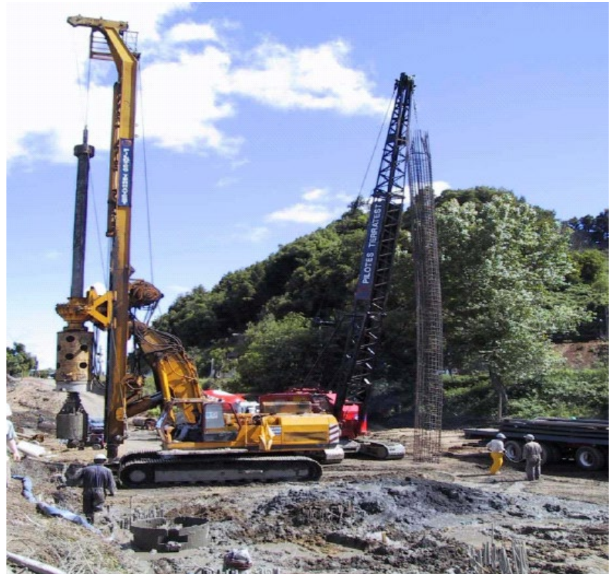
Foto 1 - Vista general de la Obra.
