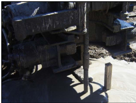
Foto 1 – Ejecución Micropilotes Ischebeck TITAN
