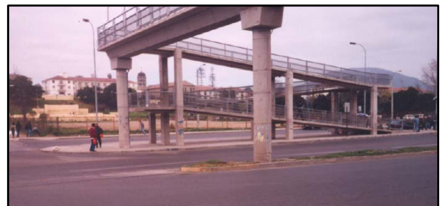
Foto 3 – Pasarela La Serena Terminada
