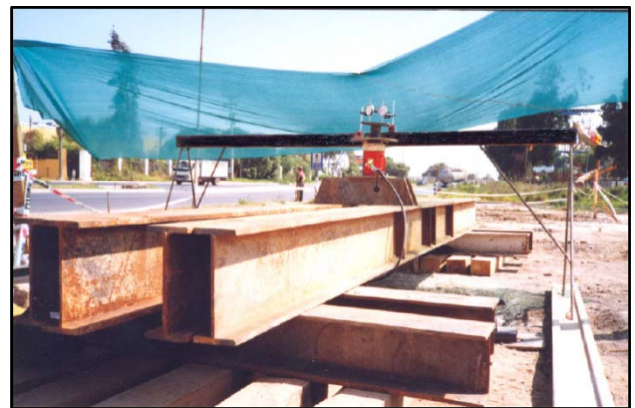
Foto 2 – Ensayo de Carga Pasarela La Serena
