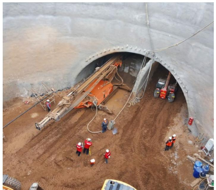
Foto 2 – Ejecución de Paraguas en Sidedrift del Túnel.
