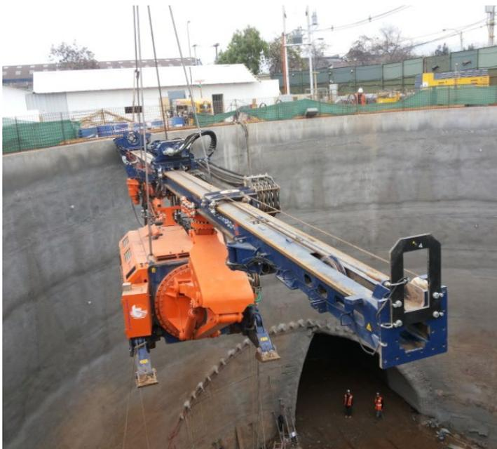
Foto 1 – Izaje del Equipo de Perforación en el Pique.
