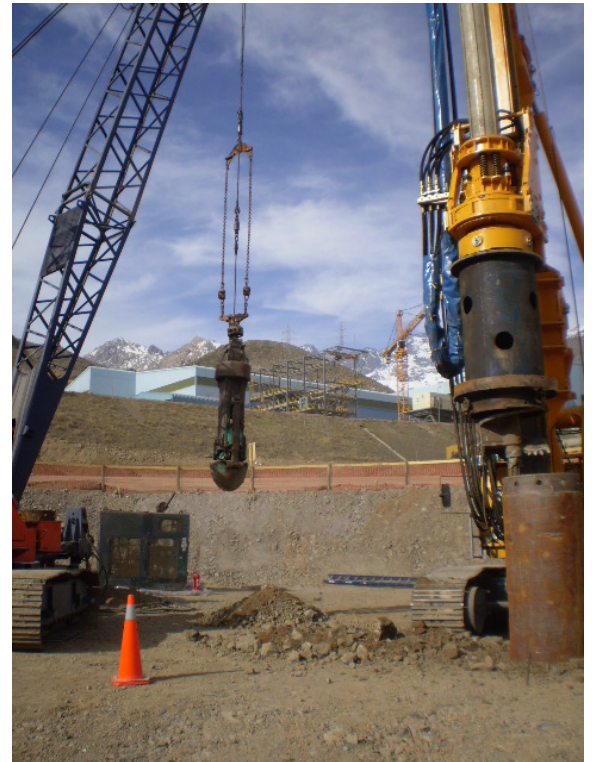
Imagen 3 – Pilotera Rotativa y Grúa ejecutando trabajos de Pilotaje en Núcleo del Espesador
