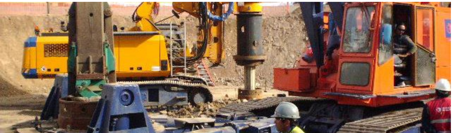
Imagen 3 – Pilotera Rotativa y Grúa ejecutando trabajos de Pilotaje en Núcleo del Espesador
