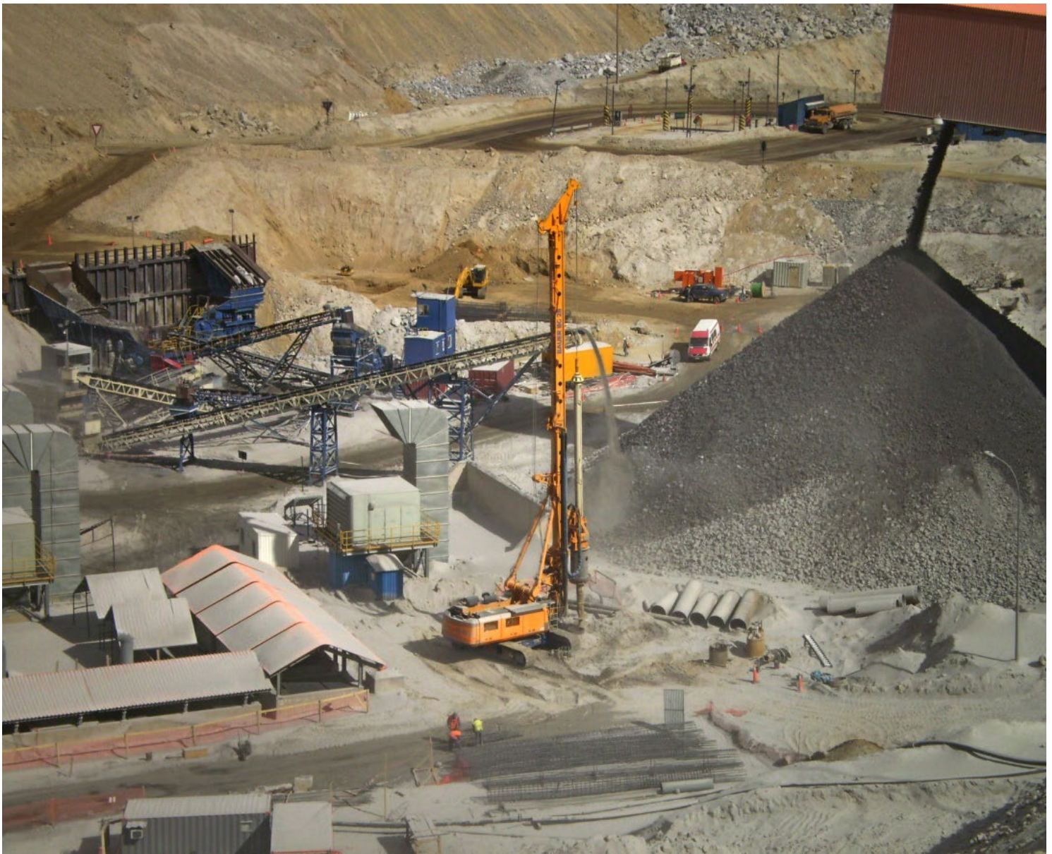
Imagen 5 – Pilotera Rotativa ejecutando pilotes en Sector Chancador Primario
