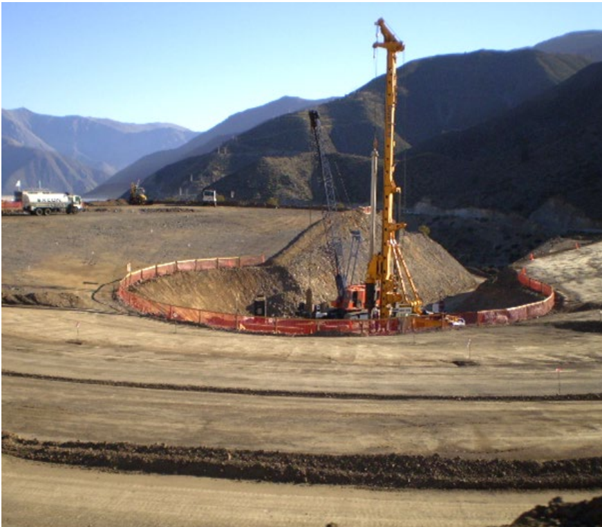
Imagen 2 – Pilotera Rotativa y Grúa ejecutando trabajos de Pilotaje en Núcleo del Espesador.
