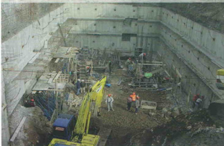
Vista de la ejecución del muro anclado en el último nivel. Nótese el espacio reducido del trabajo.
