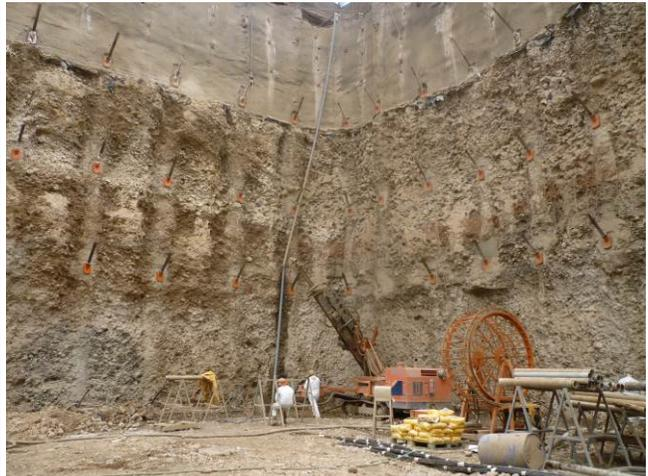
Fig. 6 – Ejecución de Jet Grouting y vista del refuerzo terminado
