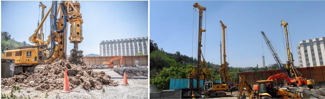
Fig. 2 – Faena de perforación y ejecución de pilotes (Pilotes Terratest S.A.)
