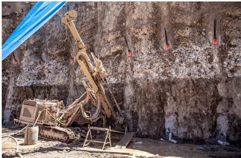
Fig. 3 – Corte esquemático con 5 líneas de anclajes y ejecución de perforaciones para la instalación de los anclajes postensados.
