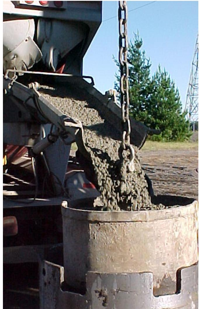
Foto 1 y 2 - Perforación y hormigonado de pilotes
