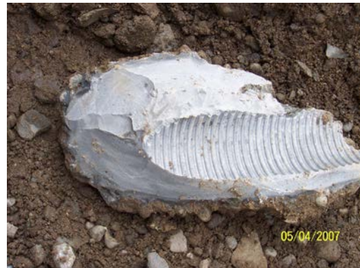
Figura N°15: Detalle del bulbo en los micropilotes
