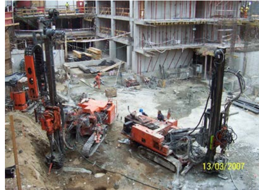
Figura N°16: Ejecución de los micropilotes
