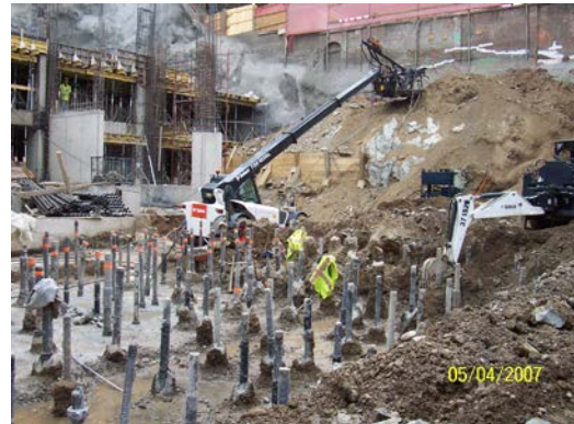
Figura N°17: Distribución final de los micropilotes
