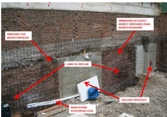
Figura 3. Paneles secundarios en proceso constructivo del muro anclado. Foto obra "Edificio Cipreses".
