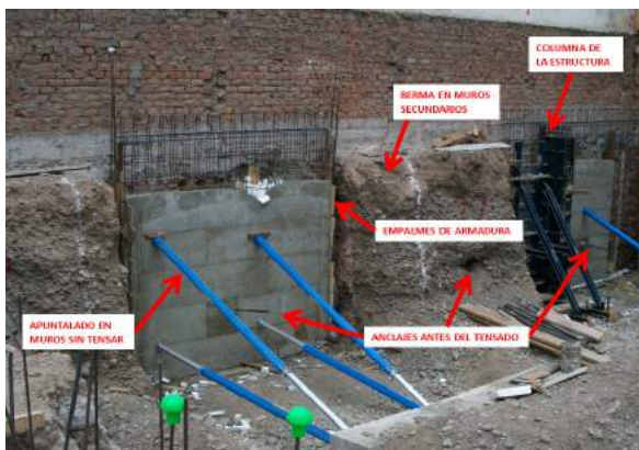
Figura 2. Paneles primarios en proceso constructivo del muro anclado. Foto obra "Edificio Cipreses".
