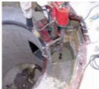
Perforación rotativa con extracción de testigo a lo largo del tramo de hormigón armado en las estaciones.
