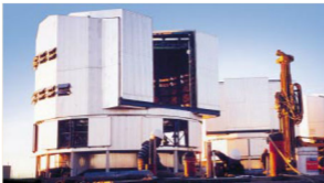
En primer plano se perfora con testigueras el tramo de hormigón armado de las estaciones. En segundo plano avanza ya la perforación en roca.
