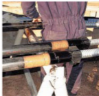
Preparación de anclajes: Detalle de la zona de unión longitud de bulbo-longitud libre. Véase el manguito pintado con epoxy en dos capas y la cinta que asegura el tubo plástico sobre el manguito. Obsérvese el centrador f 112 mm que garantiza un recubrimiento mínimo de grout de 30 mm sobre la barra.
