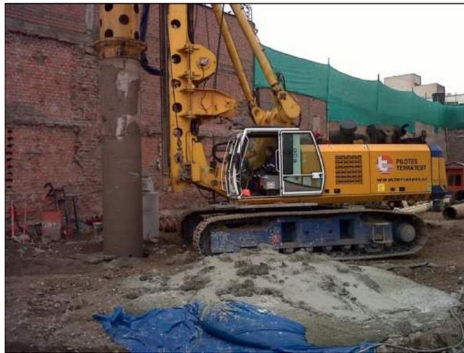
Foto 2. Foto durante la perforación de un pilote columna de 1m de diámetro mediante máquina piloto tipo Bauer BG-24
