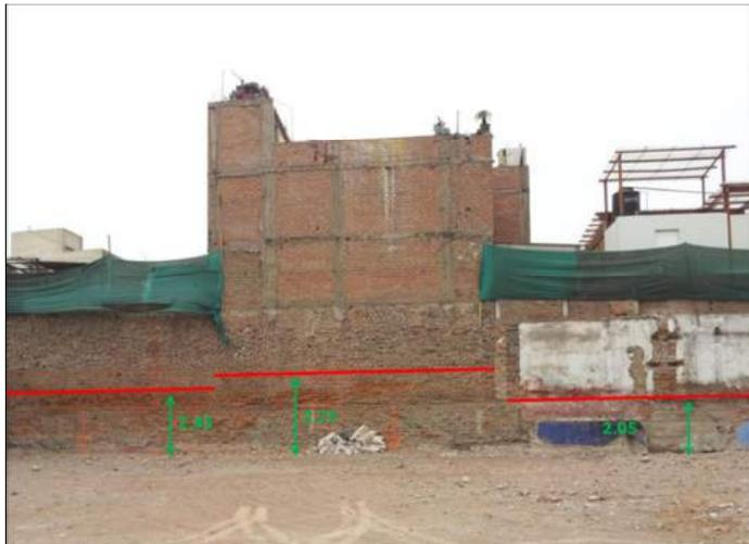
Figura 7. Nivel 0.0 del proyecto quedaba hasta 2.75m por debajo del nivel superior del relleno
