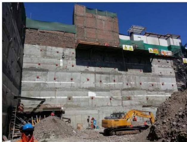
Foto 5. Se aprecia el muro del eje 7 del proyecto concluido con las 5 líneas de anclajes ejecutadas.
