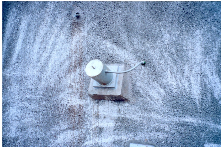
Foto 5 – Anclaje con celda de carga
