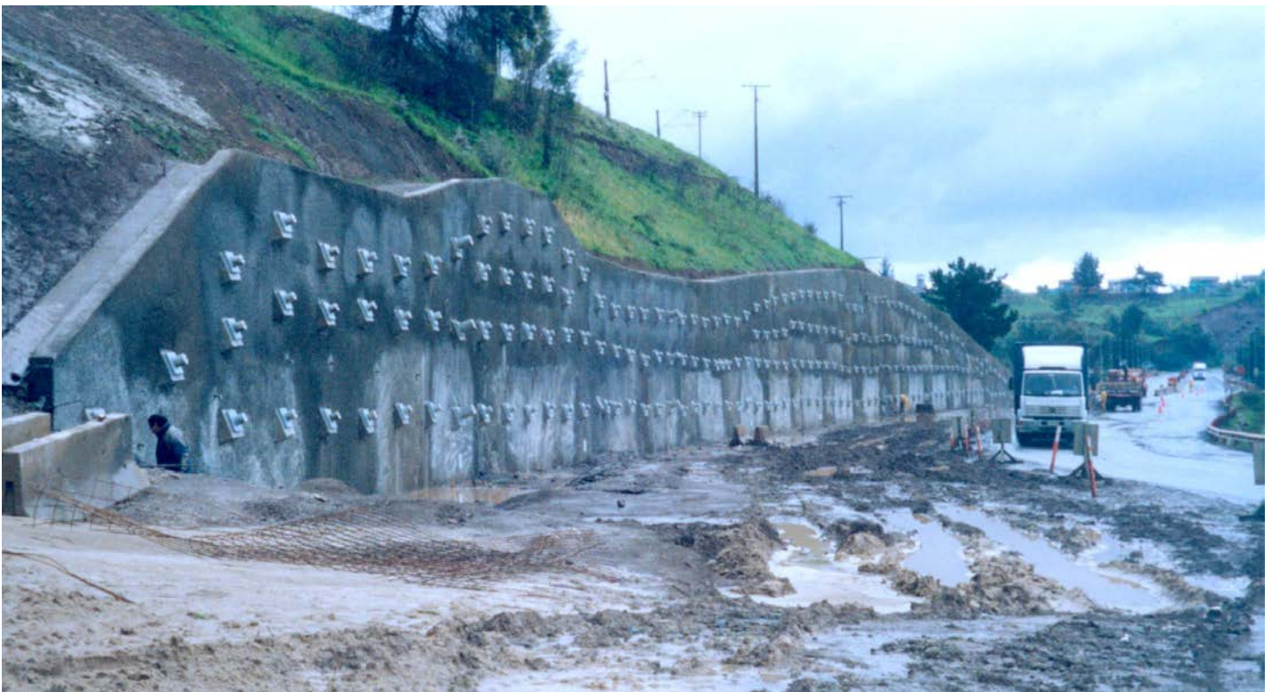
Foto 1 – Vista general de la Obra
