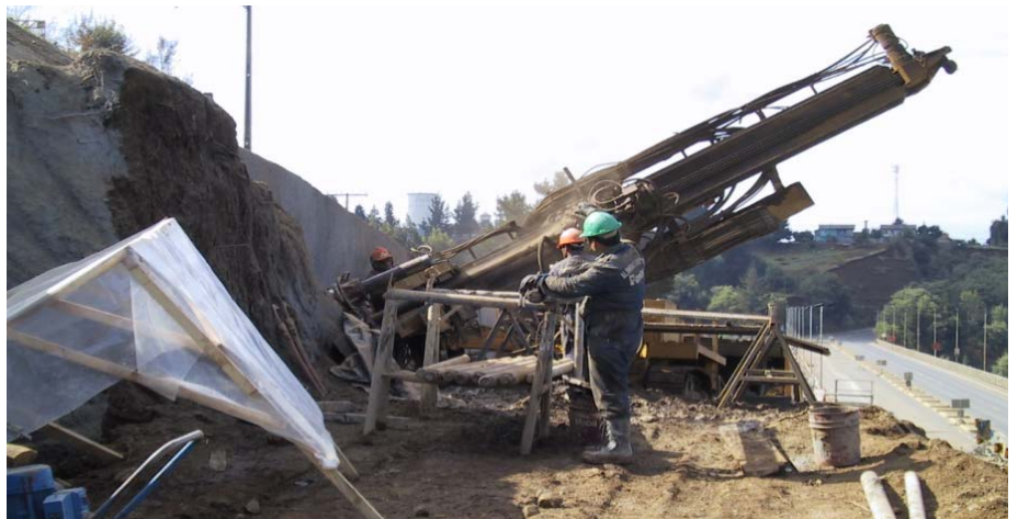
Foto 3 – Ejecución de los Anclajes
