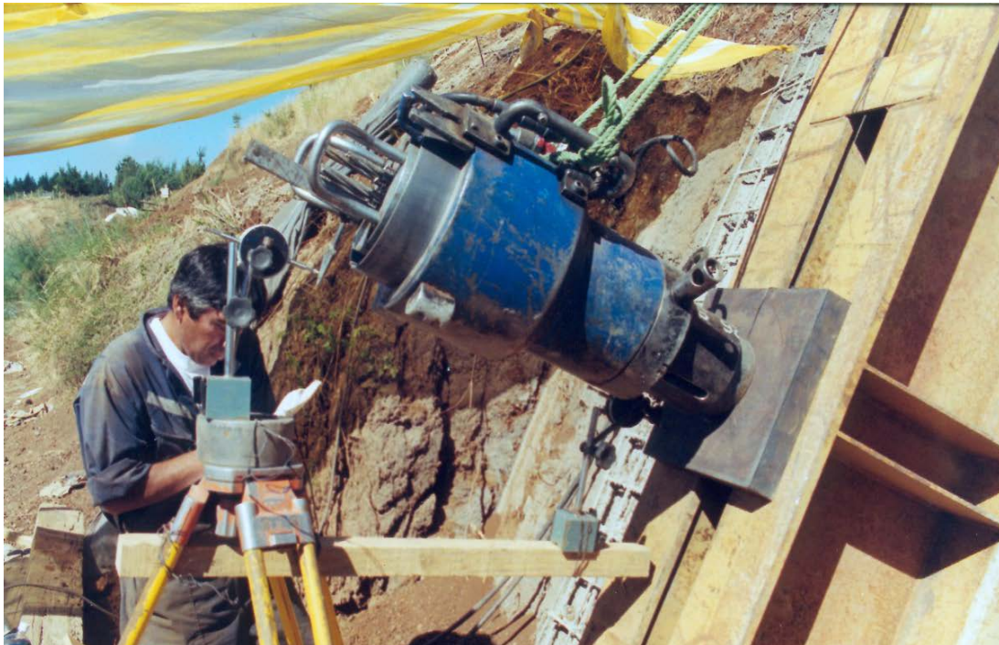
Foto 4 – Tensado de Anclajes
