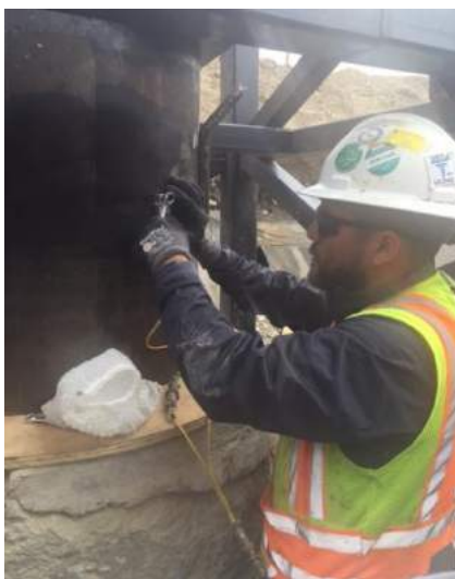
Figura 9. Instalación de sensores.
