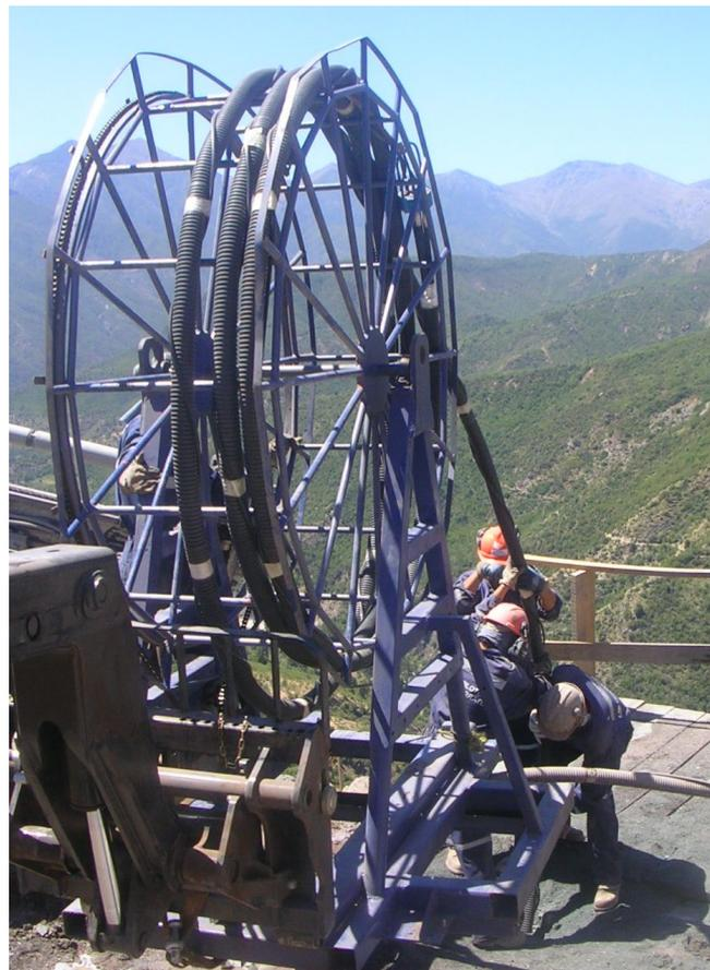
Foto 2- Instalación de los cables de los anclajes de 20m aproximadamente.
