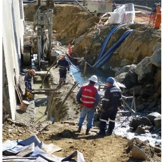
Imagen 6 – Micropilotes e Inyecciones bajo la Ataguía.
