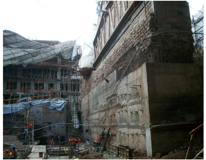
Figura 11. Idealización del cuerpo de tierra armado con soil nailing
