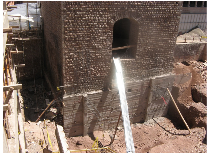
Figura 13. Acabado definitivo de la estructura de TERRANAIL por debajo de las estructuras coloniales
