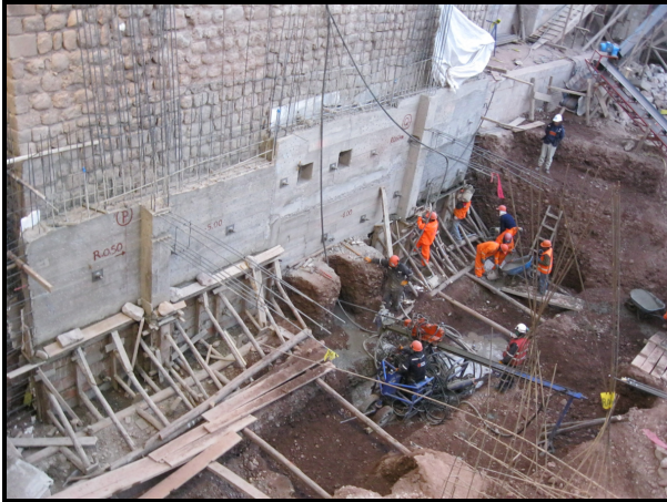
Figura 9. Perforación de los Nails en espacio reducido utilizando una máquina perforadora portátil del tipo Morath
