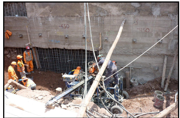
Figura 5. Método constructivo del TERRANAIL realizado por bataches y en alturas de excavación menores a 2m
