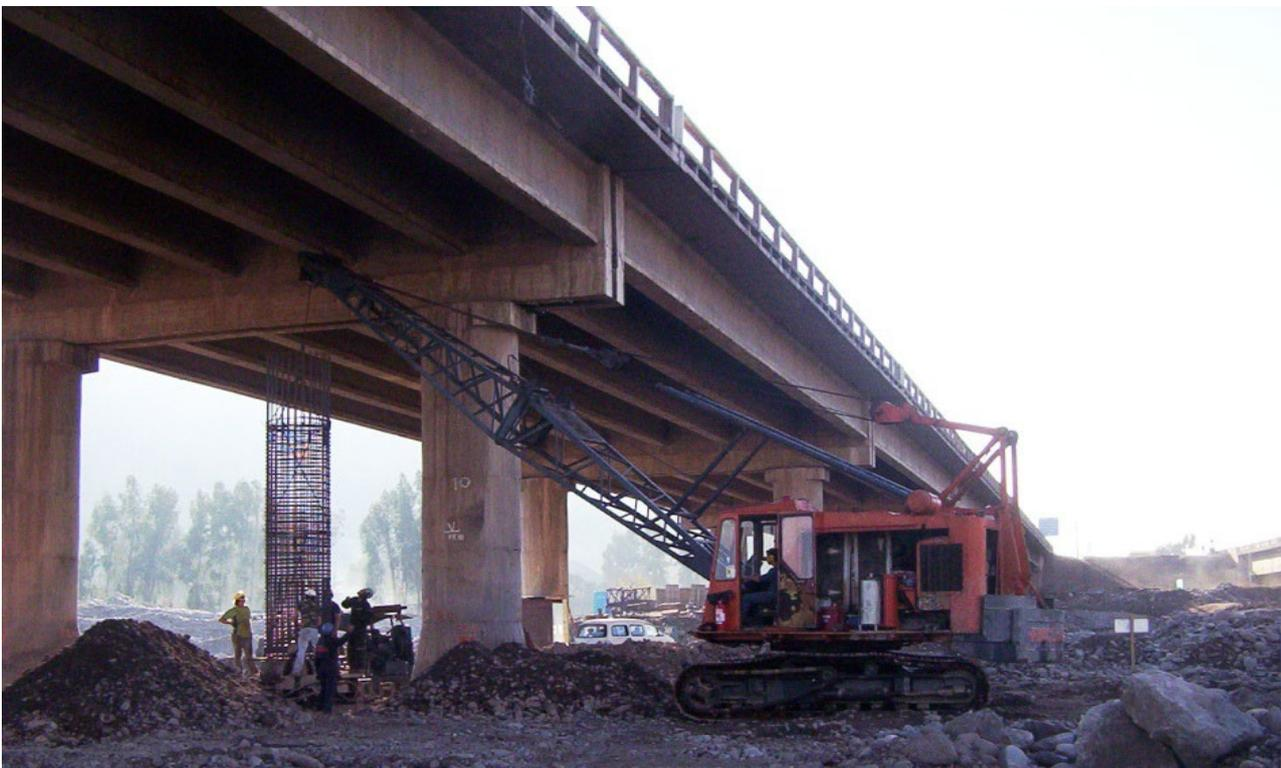
Fotos 4 y 5 – Instalación de tremie y armadura respectivamente.
