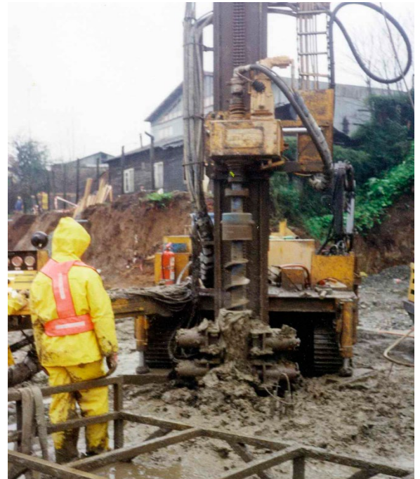
Foto 1 – Perforación con hélice y encamisado.
