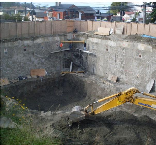
Foto 1 – Vista del Muro Pantalla y Excavación general
