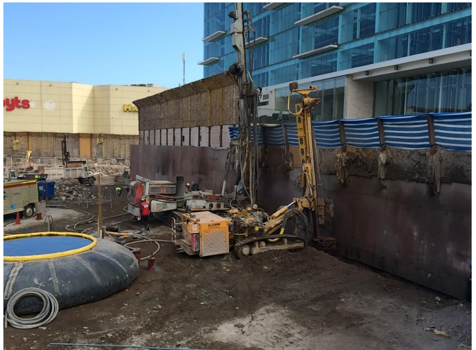
Foto-1 Vista de la obra en ejecución.
