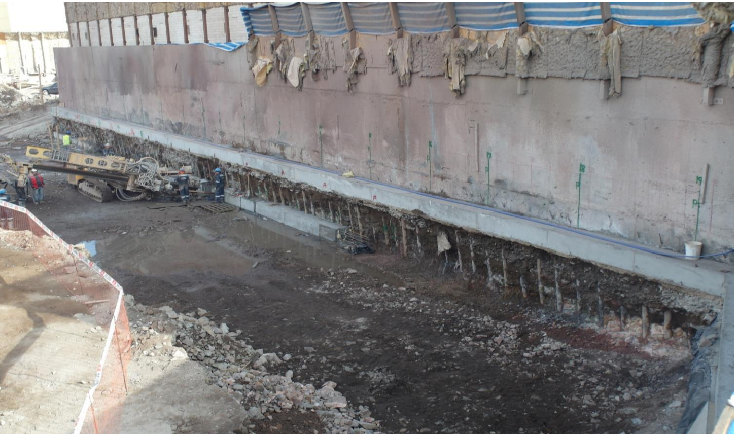
Foto 5 - SECTOR E – EDIFICIO HOTEL TERRADO II – Pantalla de micropilotes y viga de coronamiento anclada (ver Fig-3)
