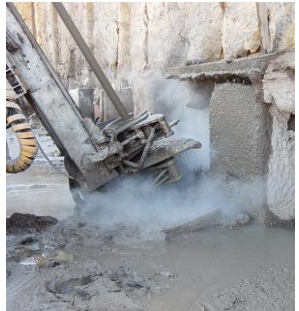
Foto-3 Ejecutando paneles de Jet Grouting.
