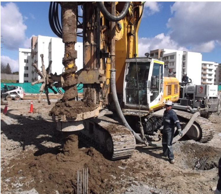
Otros proyectos de Pilotes CFA, Condominio Jardín Urbano II, Valdivia.
