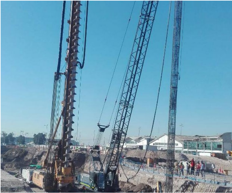
Pilotes CFA proyecto Condominio Parque Krahmer en Valdivia.
