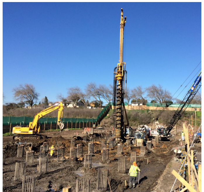
Otros proyectos de Pilotes CFA en proyecto Edificio Paicavi, Armas, Concepción.
