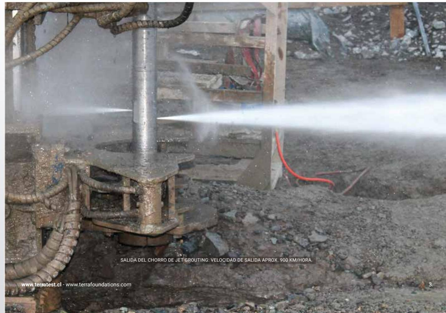
SALIDA DEL CHORRO DE JET GROUTING: VELOCIDAD DE SALIDA APROX. 900 KM/HORA.
