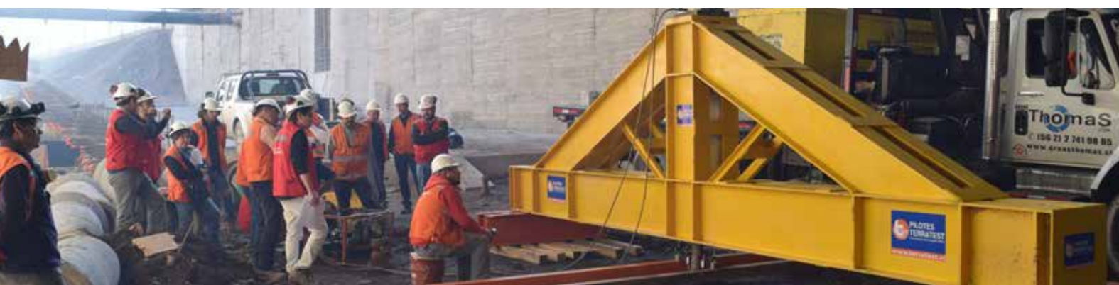
ENSAYO DE CARGA A MICROPILOTES DEL TÚNEL KENNDY ZUJOVIC.
