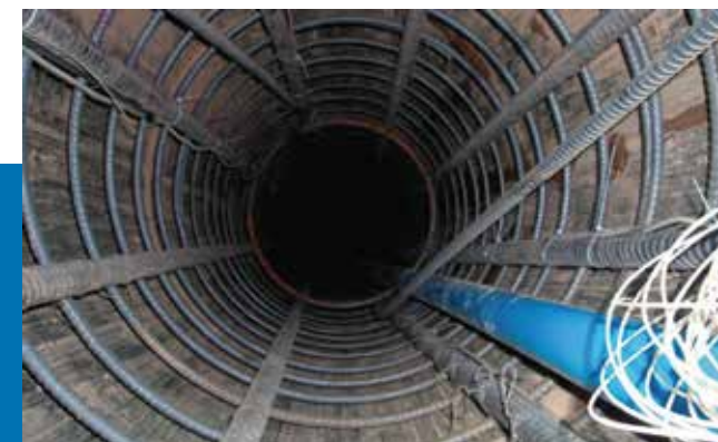
INSTALACIÓN INCLINOMETROS, EDIFICIO ESCUELA DE INGENIERÍA U. DE CHILE.
