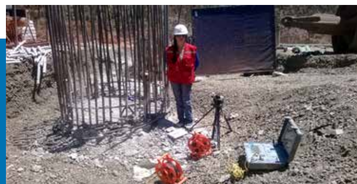
ENSAYO CSL, VIADUCTO LAS CHILCAS PILOTES DE Ø 2000 mm.
