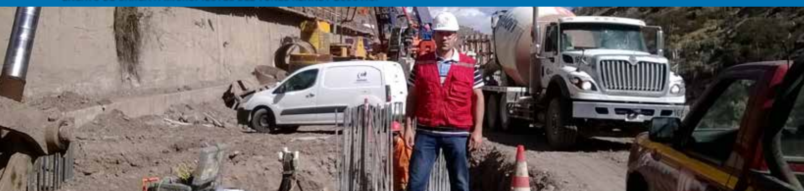
ENSAYO CSL DE INTEGRIDAD A PILOTES. MEJORAMIENTO VIADUCTO LAS CHILCAS
