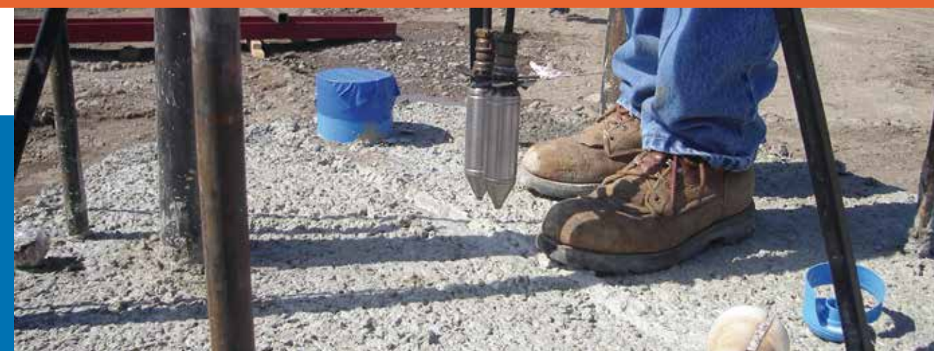
SONDAS ENSAYO CSL, PLANTA COKER RPC.
