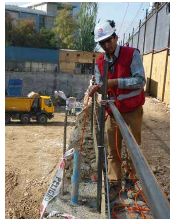
MEDICIÓN INCLINOMETROS, EDIFICIO CERRO EL PLOMO.
