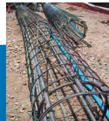
INSTALACIÓN INCLINOMETROS, EDIFICIO ESCUELA DE INGENIERÍA U. DE CHILE.
