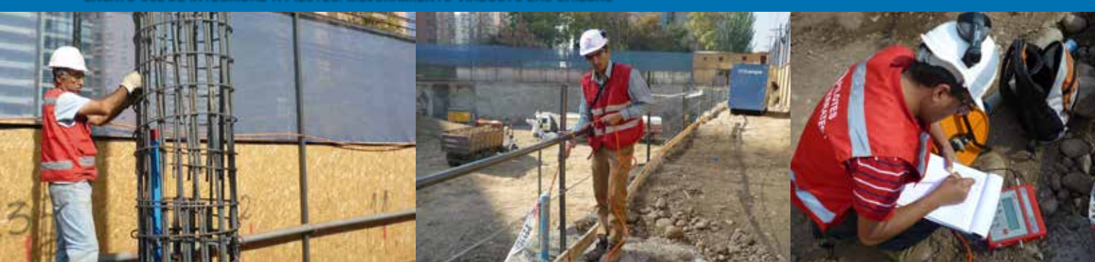
INSTALACIÓN INCLINÓMETROS, EDIFICIO CERRO EL PLOMO.
