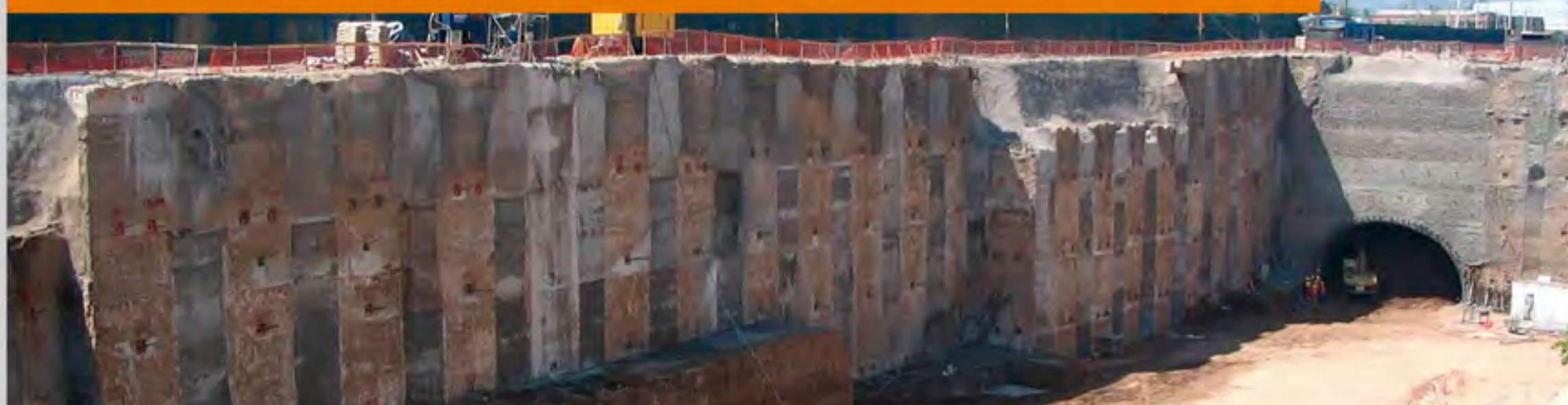
MURO PANTALLA DISCONTÍNUO DE 3.565,5 m 2 , Estación Vespucio - Recoleta, Metro de Santiago.
