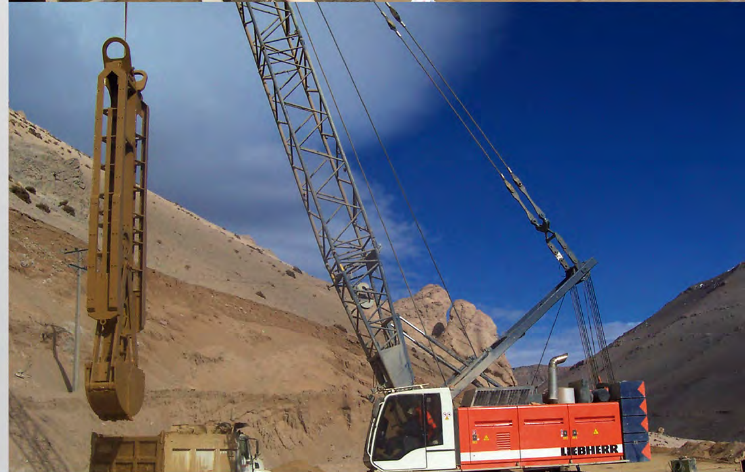
MURO PANTALLA, Mina La Coipa.
