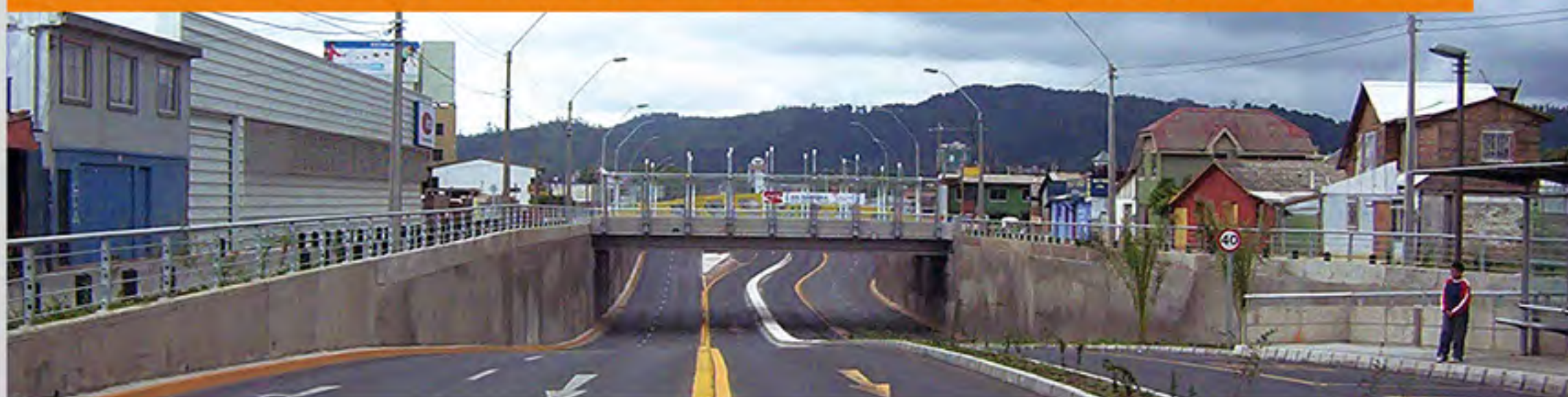
PASO INFERIOR PAICAVÍ 4.930 m 2 de muros pantalla, espesores de 40cm, 50cm, 80cm y 60cm, Concepción.
