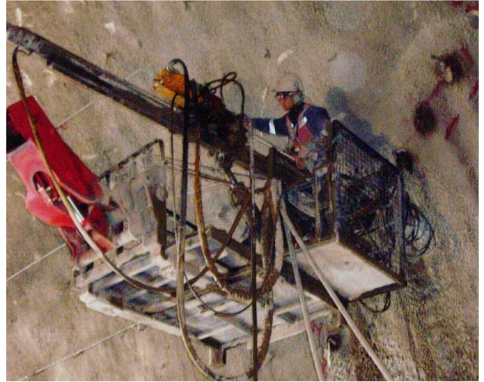
Fotos 1 y 2 - Pique Estación Las Mercedes, Puente Alto, equipo con capacidad de instalar micropilotes hasta 11 mts de altura.
