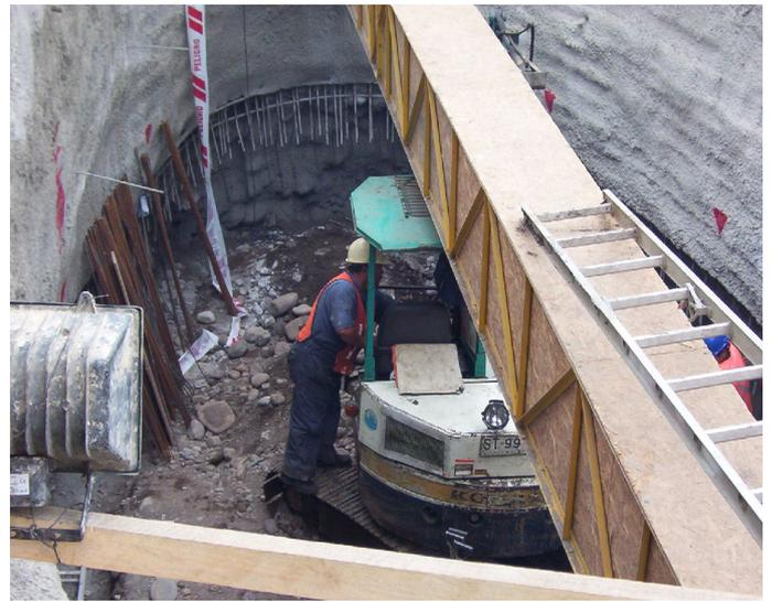
Fotos 3 y 4 - Estación Plaza Puente Alto, Pique Eyzaguirre, Puente Alto, equipo para instalación de micropilotes en sectores de poco espacio.
