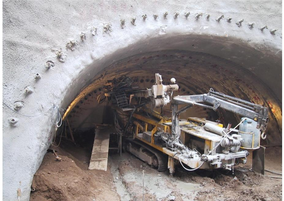
Foto 1 – Ejecución Paraguas del Túnel
