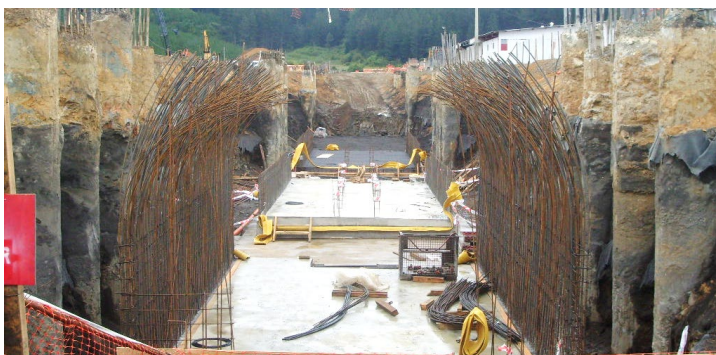
Imagen 3 – Construcción de túnel y pilotes.
