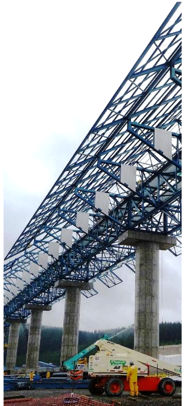
Imagen 1 – Columnas de la Correa Transportadora.
