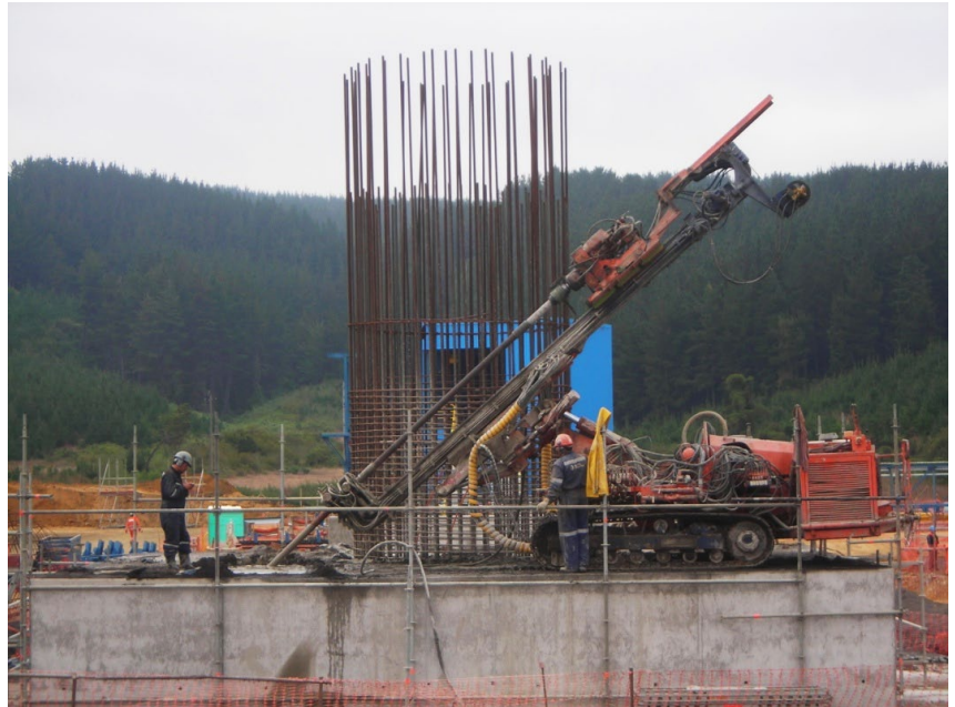
Imagen 2 – Vista de columna y perforación de micropilotes.
