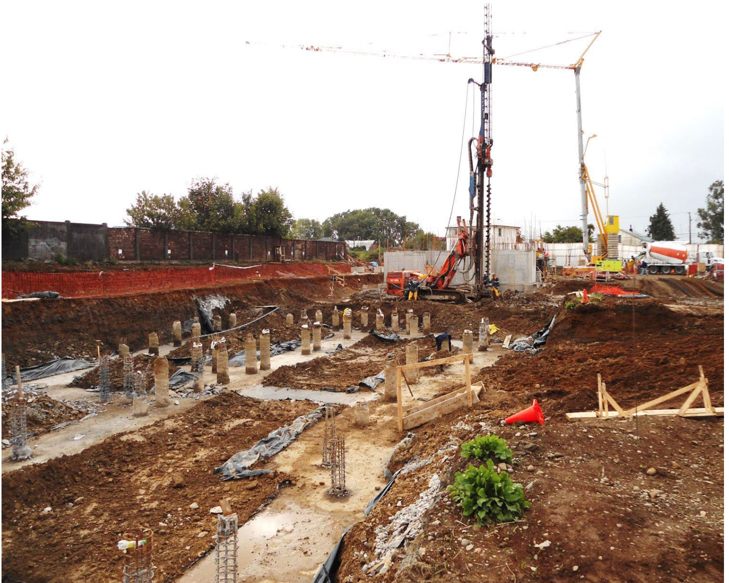
Foto 1 – Vista general de la Obra.
