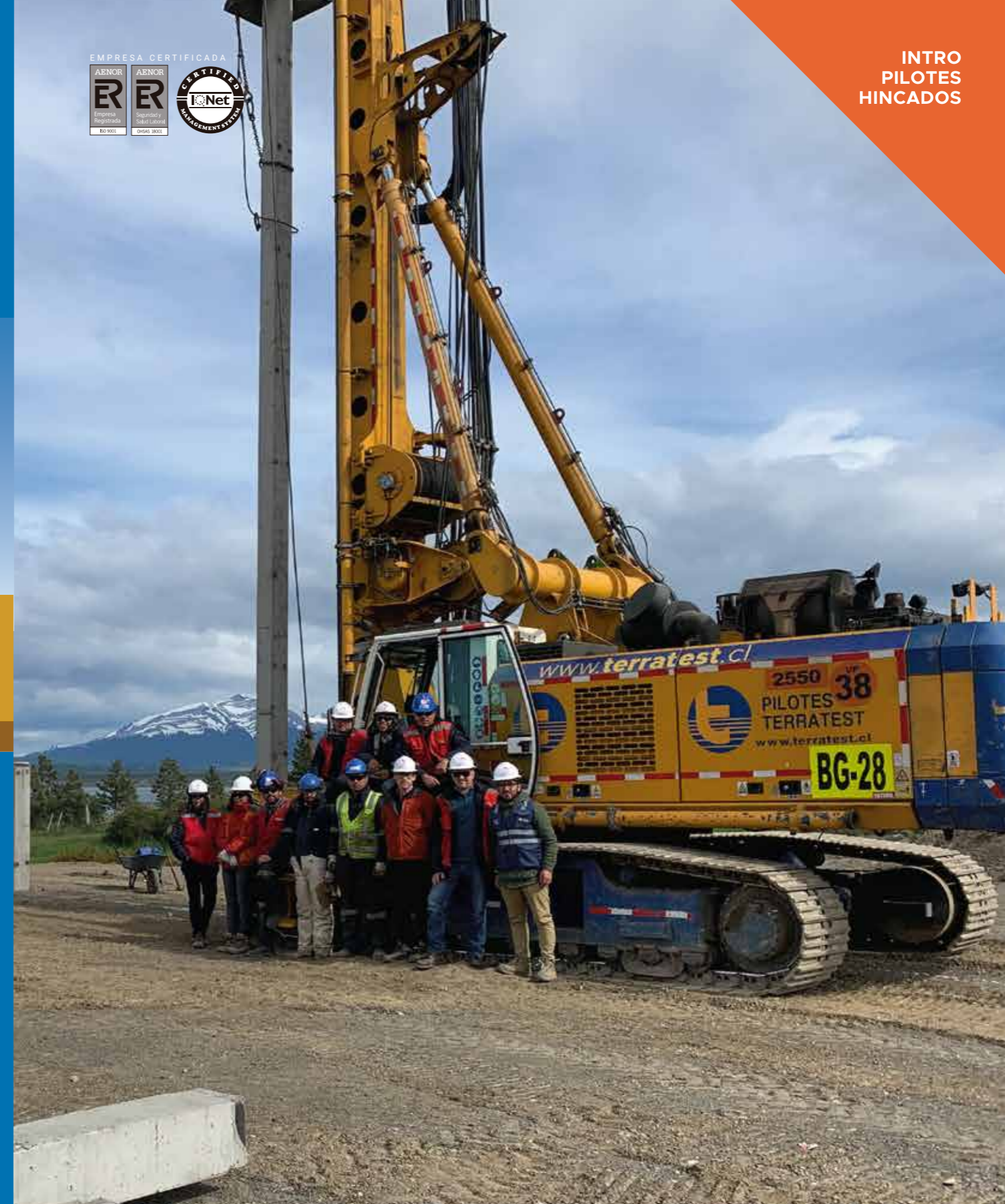
PRIMEROS PILOTES CFA Ø 1000 Y 1200 MM EN CHILE DE 15 M DE PROFUNDIDAD, PLANTA AUSTRALIS MAR, PUERTO NATALES.
