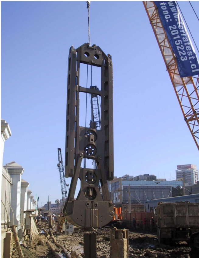
Foto 3 – Cuchara Bivalva en plena ejecución de la excavación.
