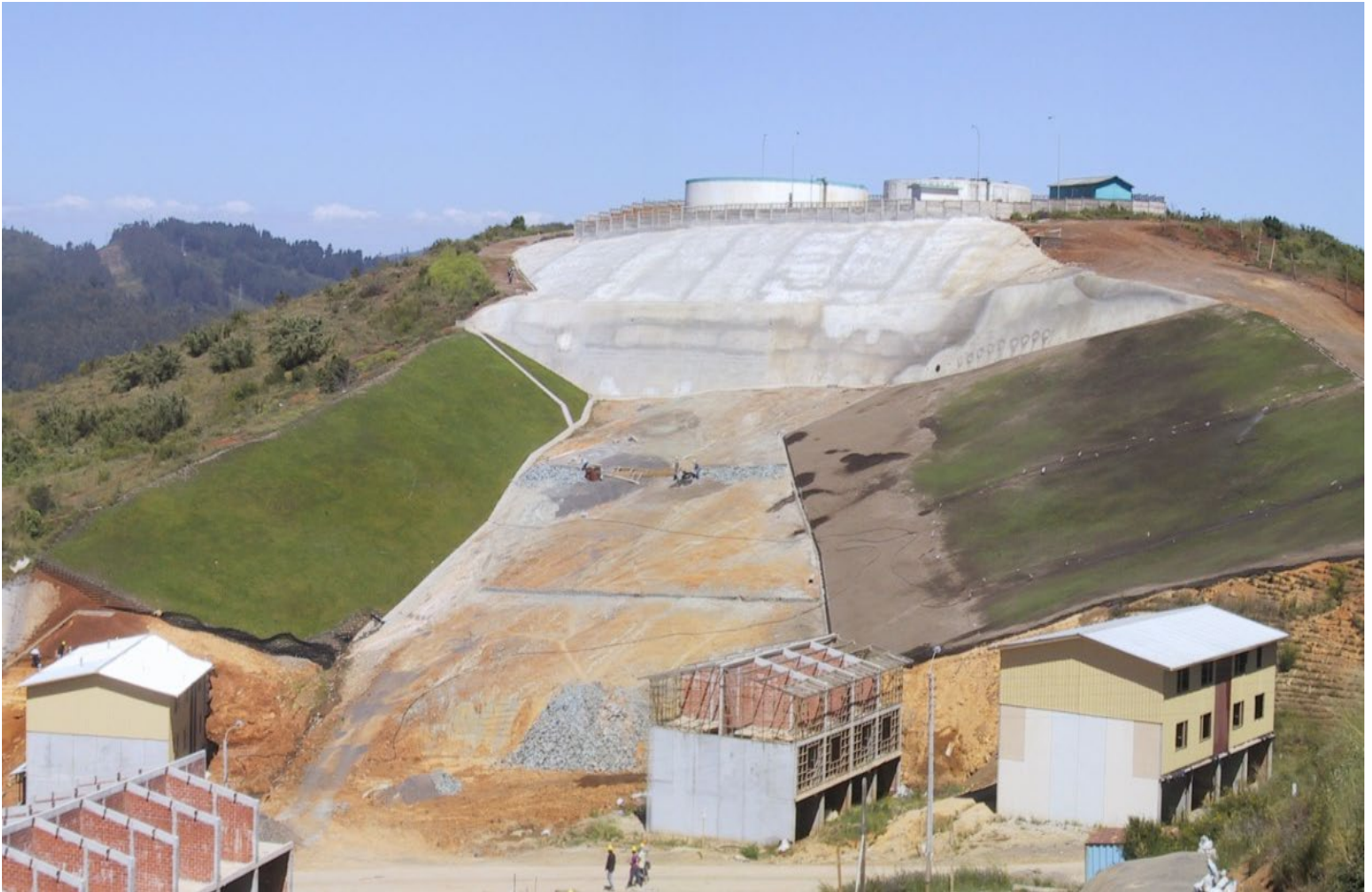
Figura 1 - Vista panorámica de la estabilización mediante Soil Nailing del Sector de tanques de abastecimiento ESSBIO. Loteo Lo Galindo
