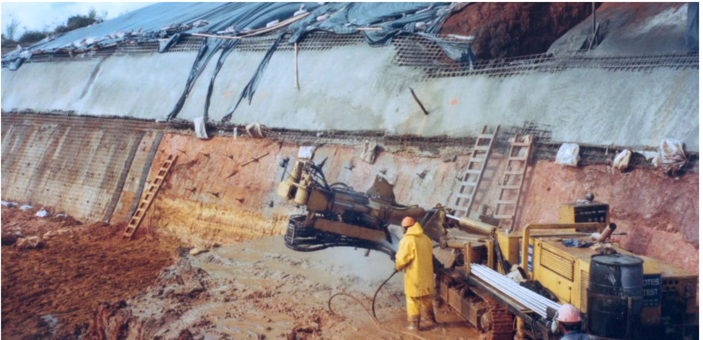
Figura 5 - Etapa de ejecución del muro en forma descendente.
