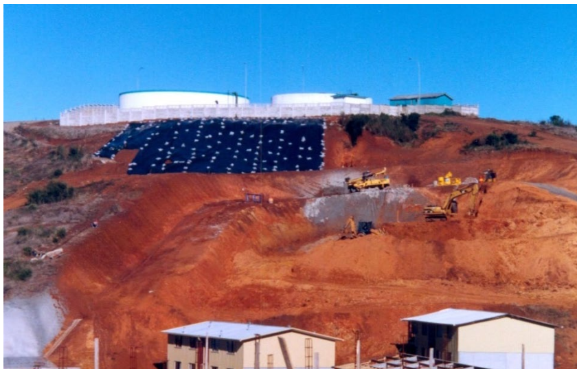
Figura 4 - Inicio de trabajos de estabilización luego de retirada gran parte de la masa de suelo deslizada.
