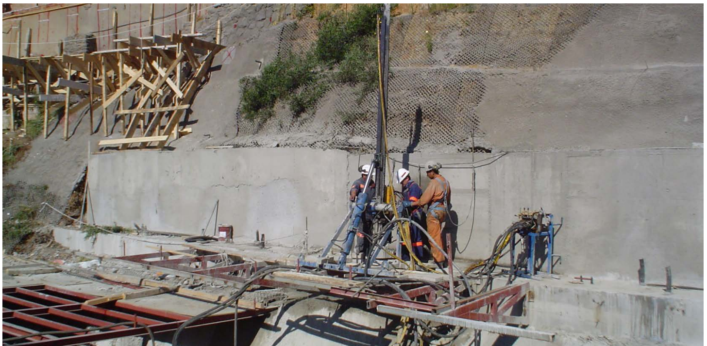
Foto 2 – Vista General de la Obra
