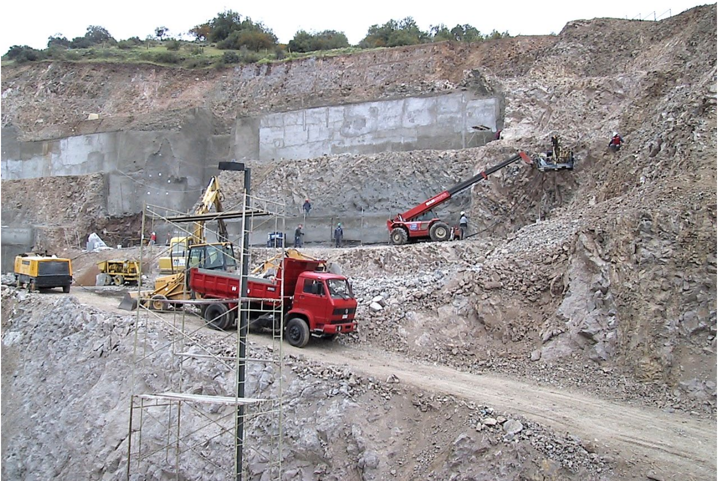
Foto 2 – Ejecución de los Trabajos.
