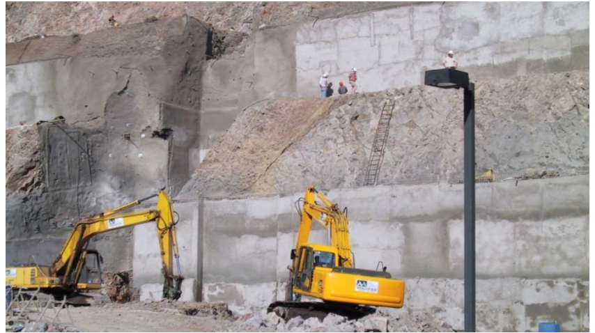
Vista de La obra.
