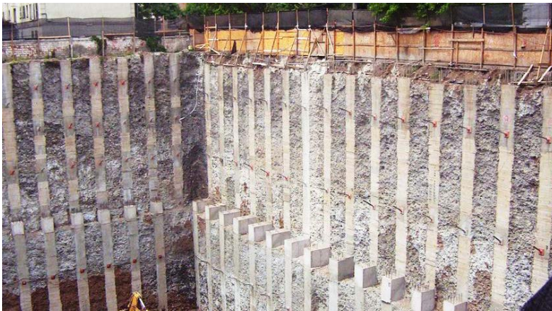
Foto 2 – Vista de las pila y seis líneas de anclajes
