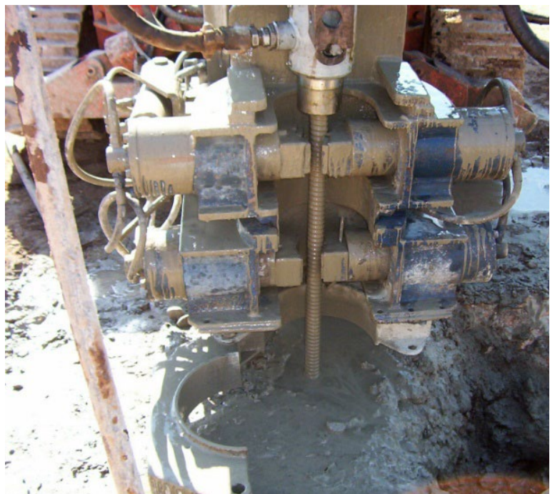
Foto 1 y 2 - Ejecución de los Micropilotes.
