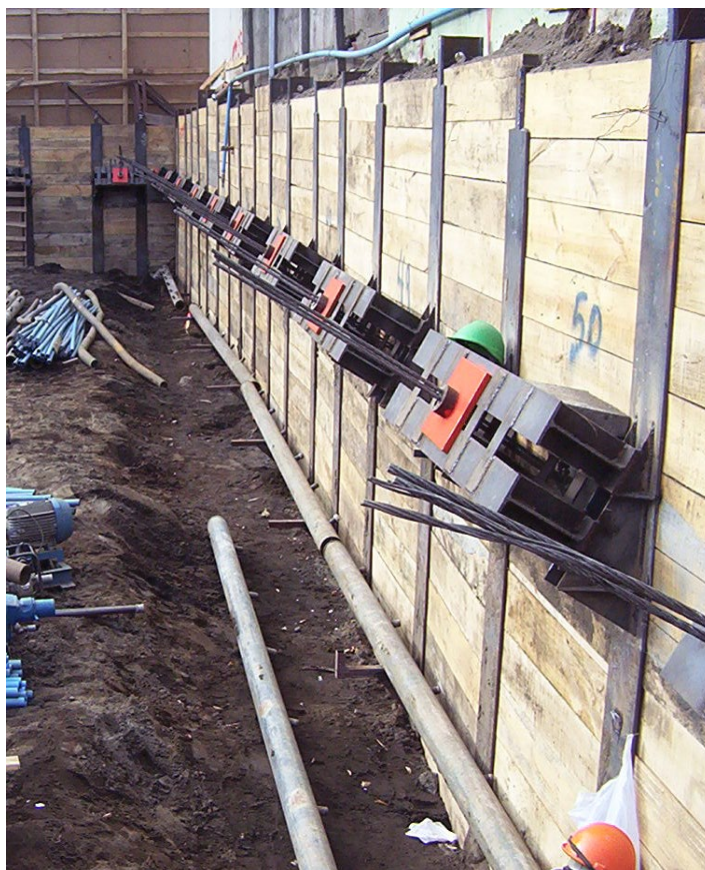
Foto 3 – Anclajes Muro Berlinés.
