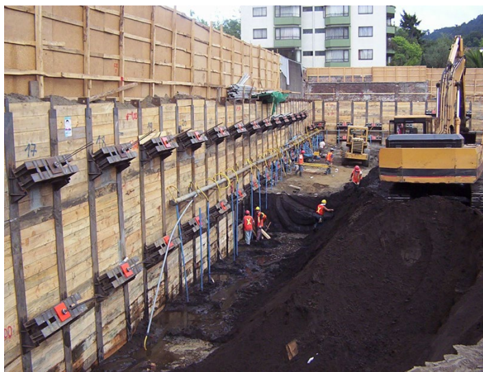
Foto 3 – Muro Berlinés en proceso.
