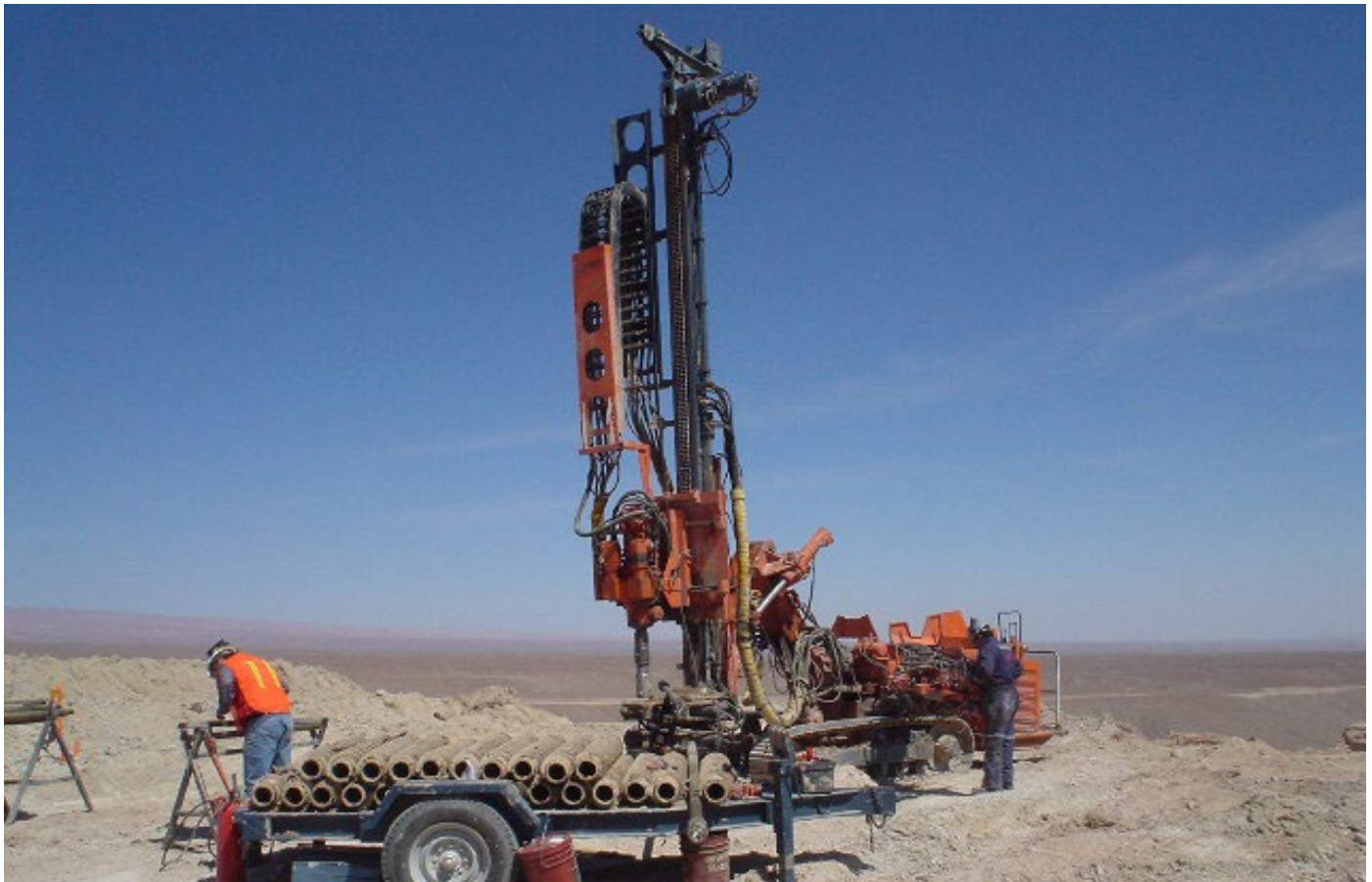
Foto 1 - Vista Ejecución Sondajes
