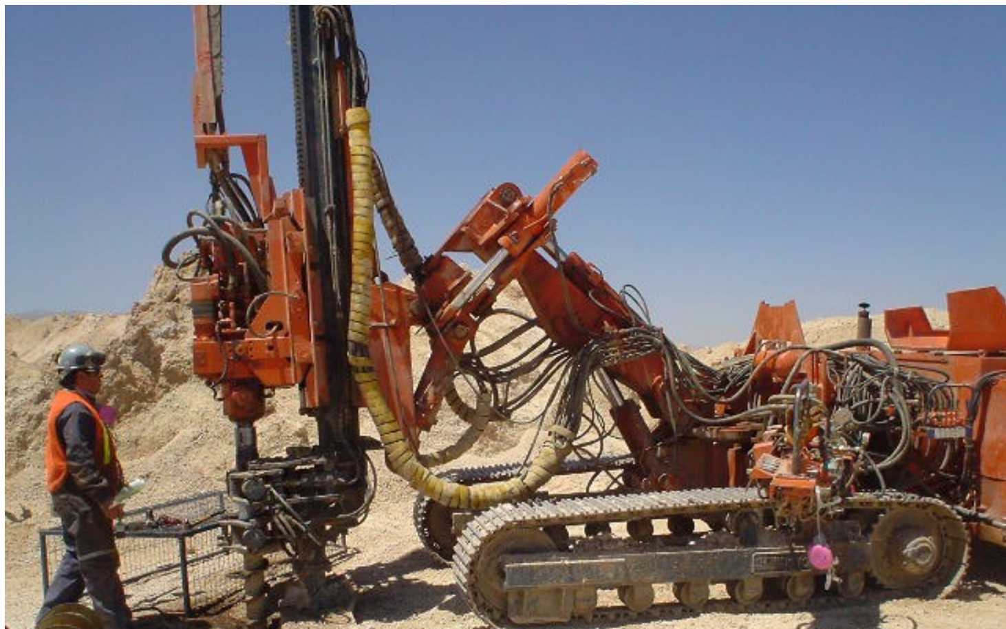
Foto 4 - Sondajes Hollow Stem Auger, Cia Minera Cerro Colorado
