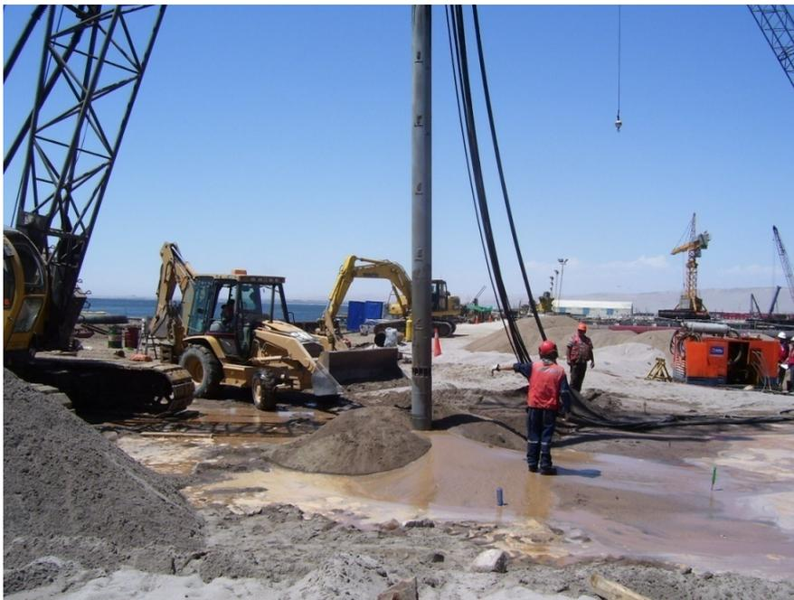
Imagen 2– Ejecución de Vibrocompactación.
