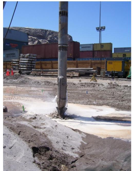
Imagen 3 – Vibrador Bauer TR13 .
