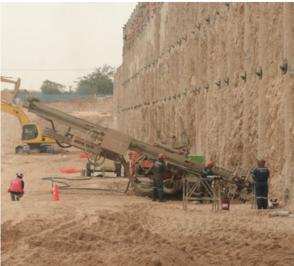
Foto 3 – Ejecución de anclajes por etapas (3ra línea de anclajes).
