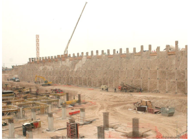
Foto 2 – Vista de la Entibación y Excavación general
