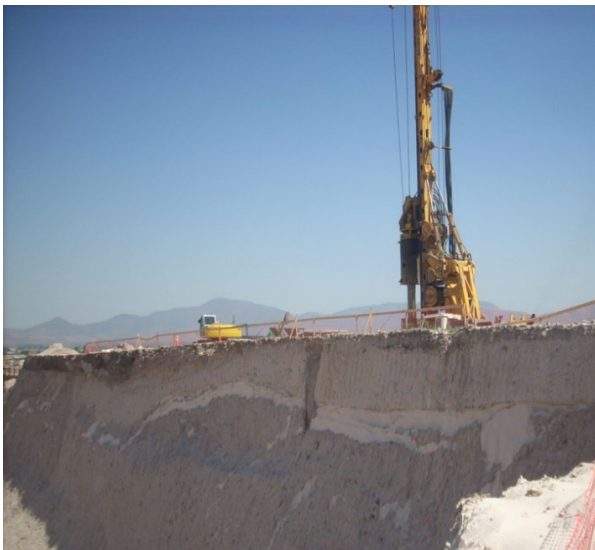
Foto 1 – Perforadora Bauer trabajando
