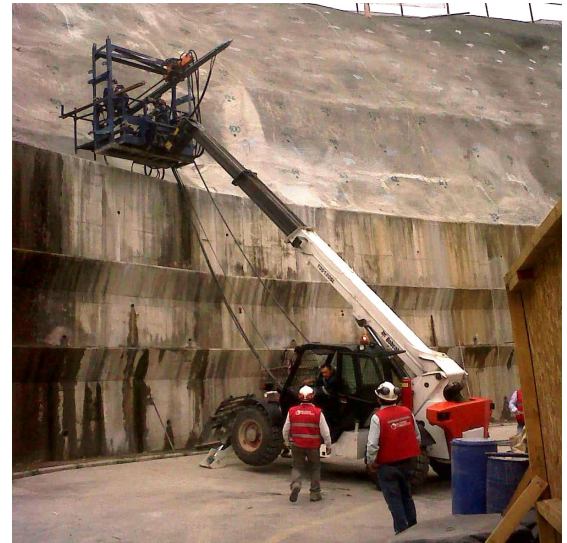
Ejecución de Pernos con Manipulador Telescópico.
