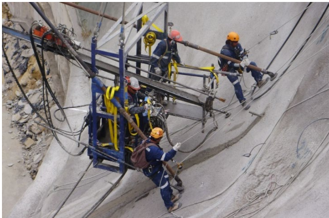
Fijación Canastillo de Perforación.
