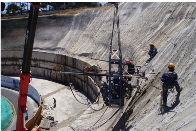
Instalación de Pernos Auto perforantes.
