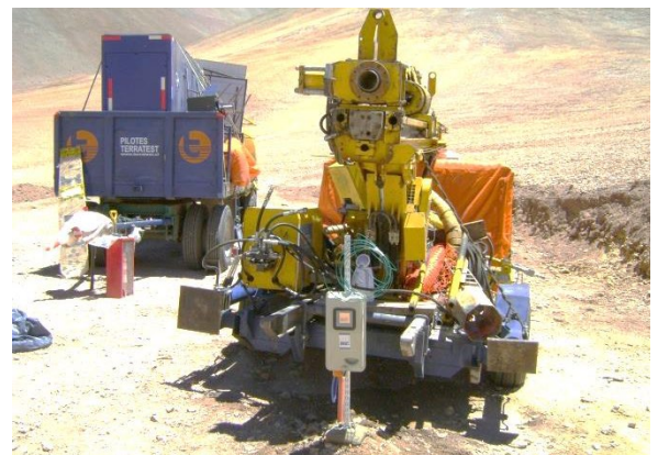
Imagen 3 – Faena de Perforación
