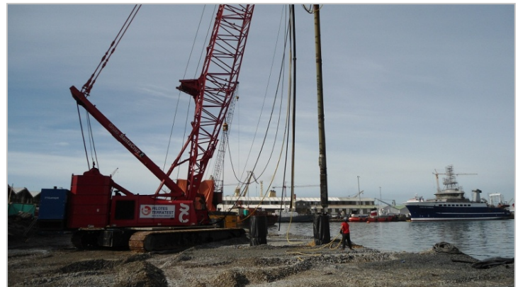
Fotos de Obra: Ejecución de Columnas de Grava – ASMAR.
