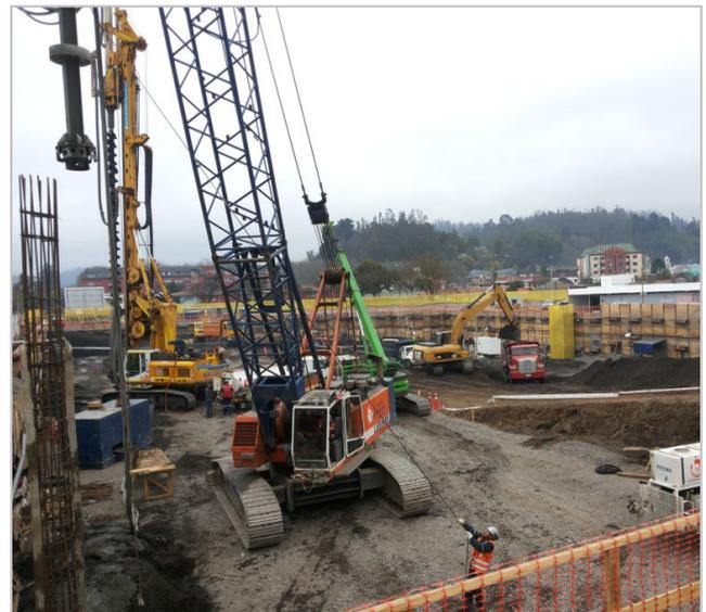
Fotografía 3 – Ejecución de Pilotes CFA.
