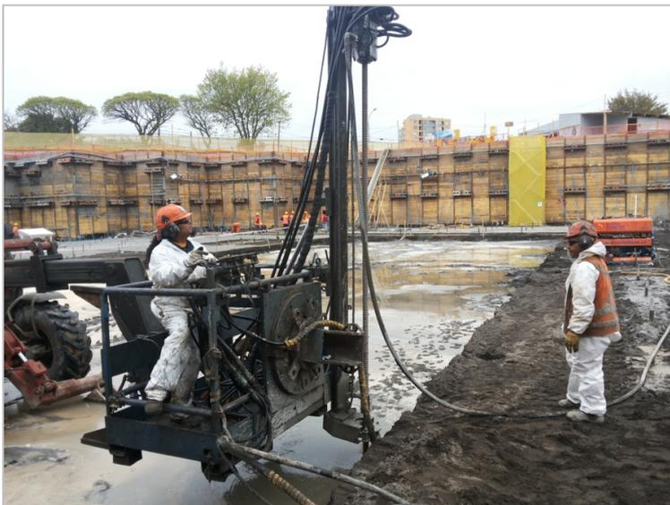
Fotografía 2 – Ejecución de Micropilotes Ischebeck TITAN.
