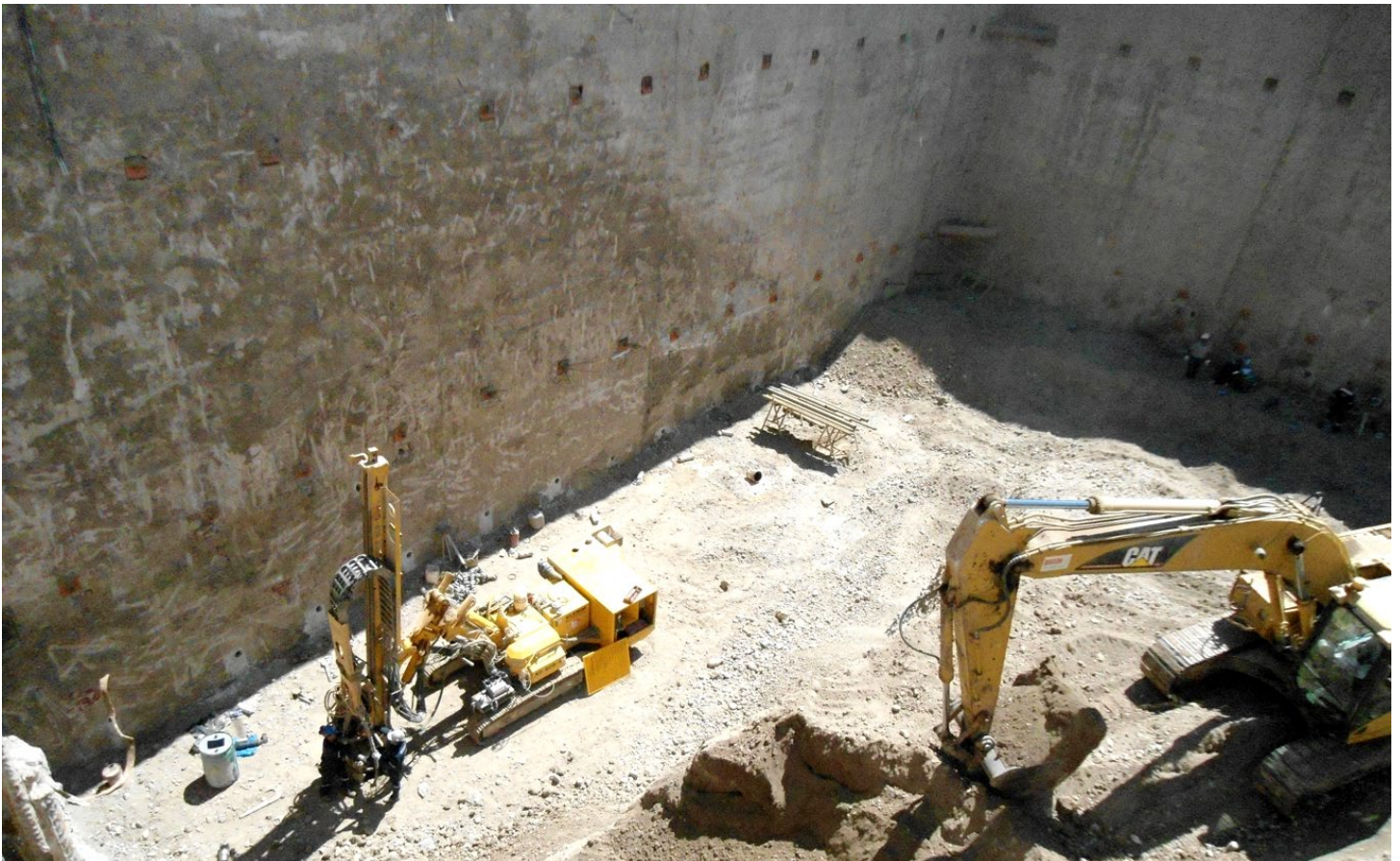
Vista general de la obra.
